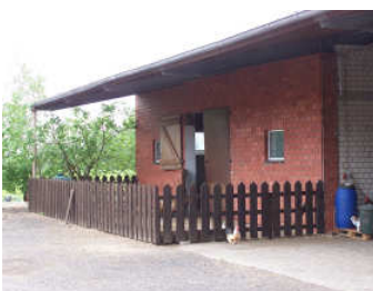
De uitloop aan de opgeknapte stal
