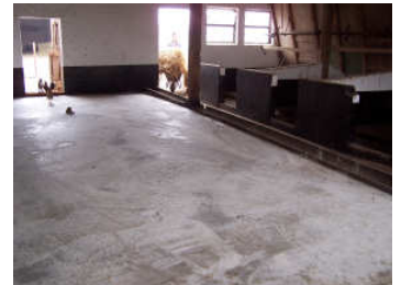
De nieuwe vloer in de kippenstal
